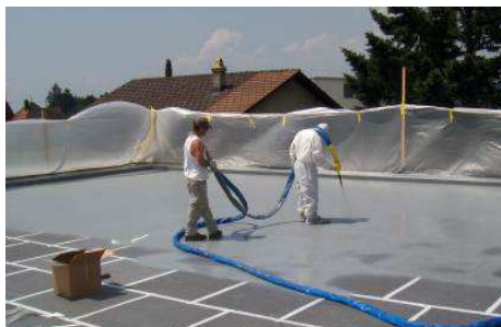
Auftragen der Spritzfolie...
