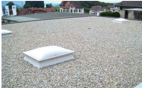
Fertiges Dach mit Schutzschicht.
