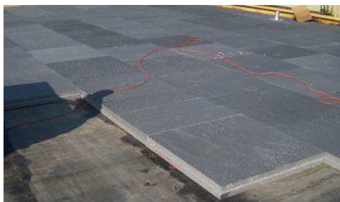
Aufkleben der Wärmedämmung...
