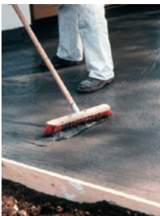
Aufbringen einer Mörtelhaftbrücke mit MasterEmaco P 511
