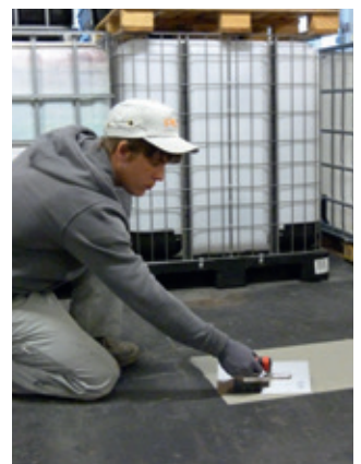
MasterEmaco S 551 in einer Produktionshalle zum Lagern und Abfüllen chemischer Produkte
