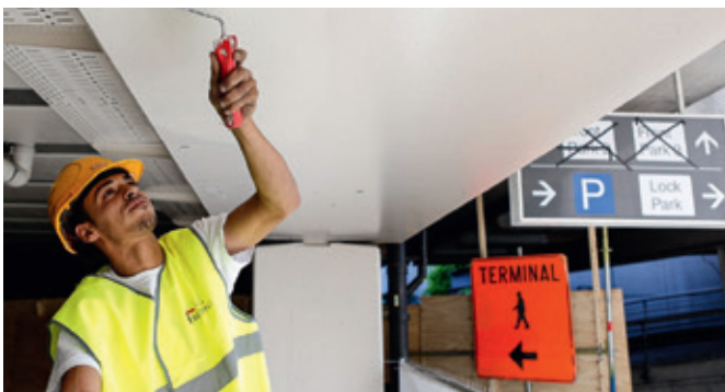
Manueller Auftrag von MasterProtect 330 EL (Parkhaus Flughafen Brüssel, Belgien)
