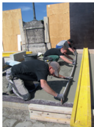
MasterEmaco S 551 auf einer Brücke nach ZTV-Ing.
